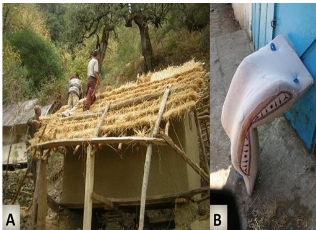
Figure 2 : Utilisations de la paille des céréales marginales : l'engrain pour les toitures (A) et le seigle dans la fabrication de bâts pour les animaux de charges (B)
