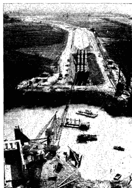
Passage de siphon du fleuve côtier du Vidourle, à la limite des départements du Gard et de l'Hérault.
