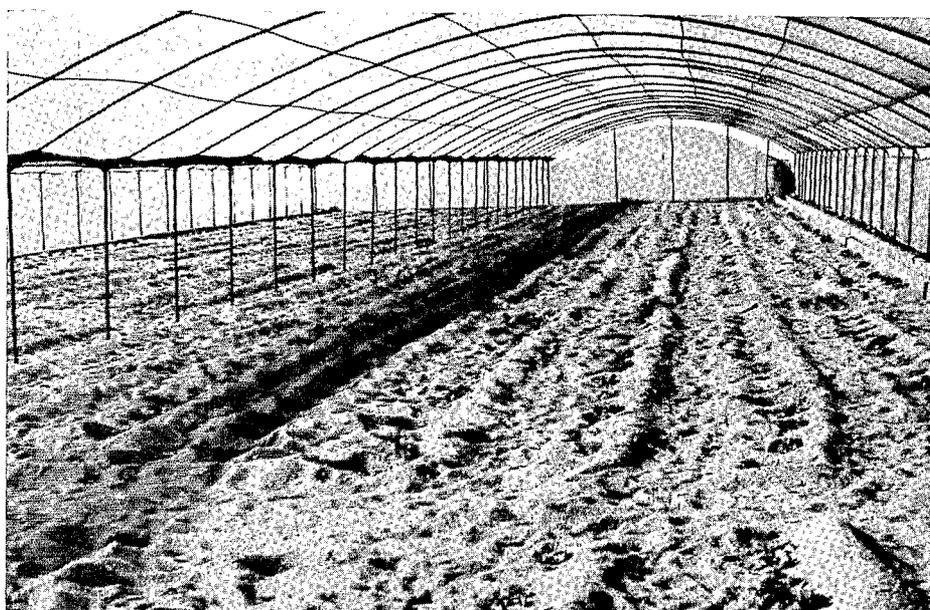
*Invernadero de estructura tubular y cubierta curva.*
