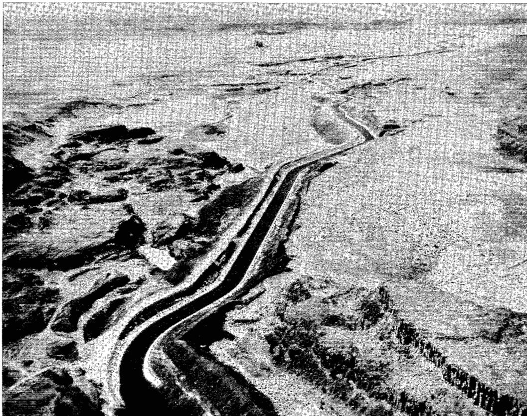
*Vue aérienne d'un canal d'irrigation qui reçoit l'eau du réservoir Grand-Coulée, sur le fleuve Columbia, et qui irrigue une étendue large de 96 km et longue de 161.*
