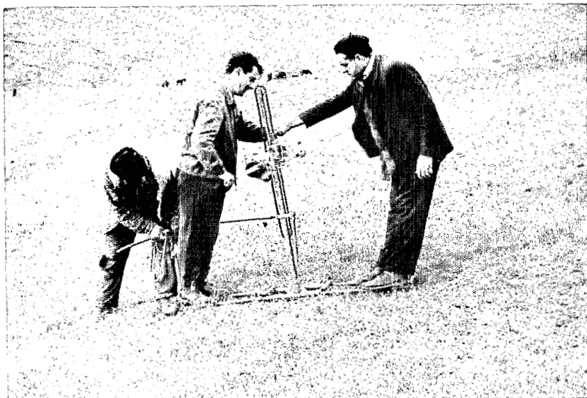
Fig. 4. — Le pénétromètre CIF (1964).
