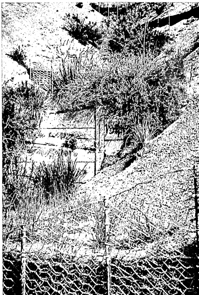
Seuil dans un lit de torrent temporaire (technique nouvelle). Alpes-Maritimes.
