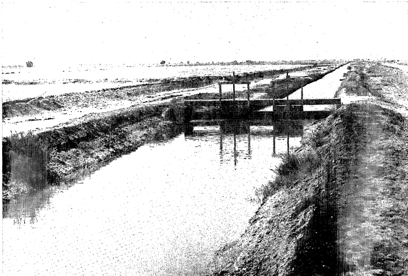
Fragment du canal principal en rive droite mis provisoirement en service avant d'être revêtu, permettant l'irrigation immédiate des premiers champs de céréales qu'il traverse.
