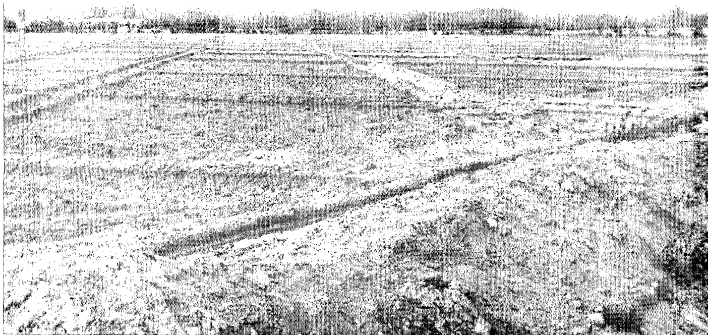
Province El Tahrir (secteur N). Vue d'ensemble du paysage agraire créé de toutes pièces en 15 ans : canal de drainage au premier plan, irrigation par gravité et submersion des parcelles.
